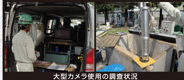
大型カメラ使用の調査状況
