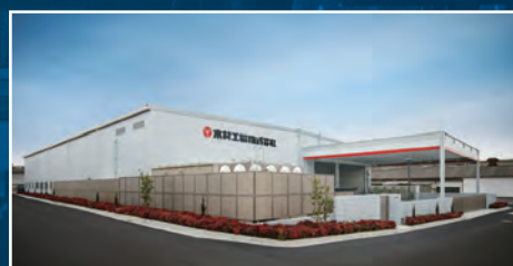
大阪府 高井田工場
