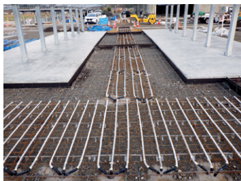
④ ヒートパイプ据付完了
