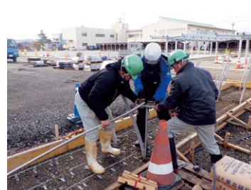
③ ヒートパイプ据付作業状況
