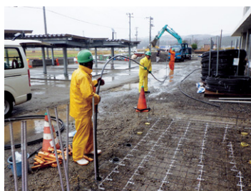
② ヒートパイプ挿入
